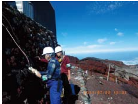
測候所の下で雷被害を調べるための接地系統の設置と測定を行う研究者(岩崎洋撮影)
