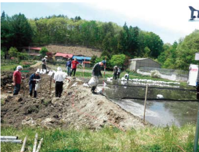
飯館村小宮の田の除染作業(これは「までい工法」より略式のやり方)
