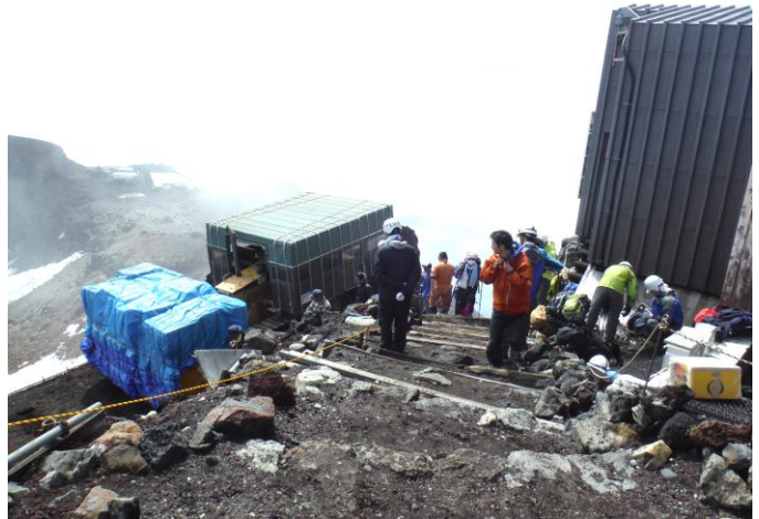
ブルドーザーで山頂測候所下まで運んだ荷物を全員で建物内に搬入 2017年7月14日 9時33分 加藤俊吾撮影
