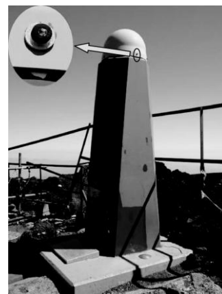
写真1 GPSの被雷個所
