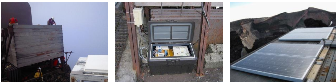
写真1 (左) 貯水槽への太陽光パネルの取り付け作業 (右上) 太陽光パネル (右下) データロガー等
