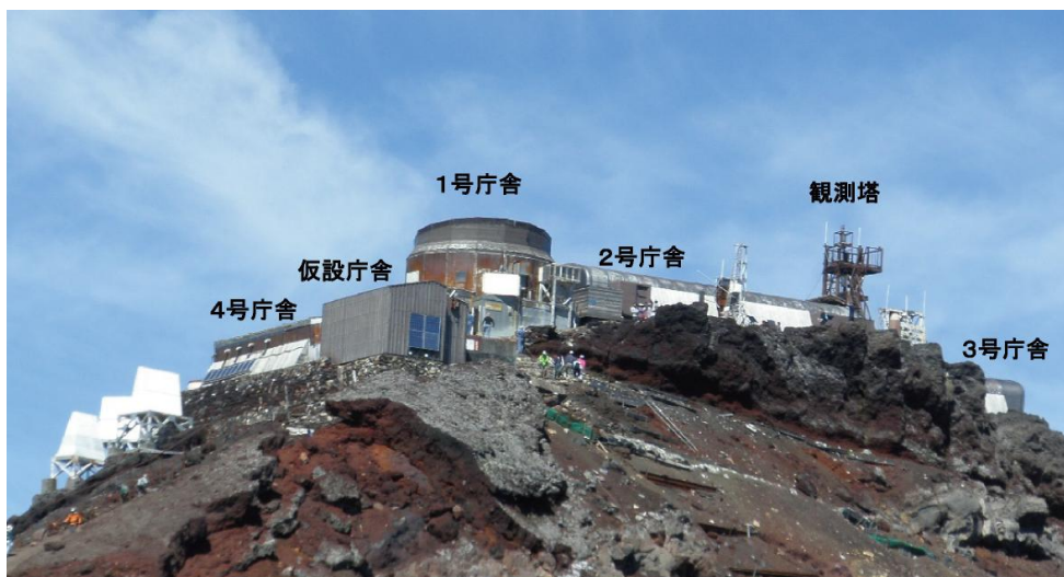
図5 富士山測候所外観 1号庁舎:鉄板壁・瓦棒葺き・鉄板の重ね屋根が混在、 2号庁舎・3号庁舎:モノコック、4号庁舎・仮設庁舎:屋根・壁とも瓦棒葺き
