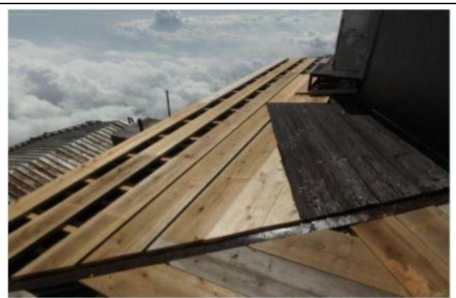
保全前：屋根鋼板はサビで腐食している。
