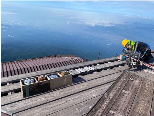
図2 一号庁舎屋根に設置した2種のフィールドミル
