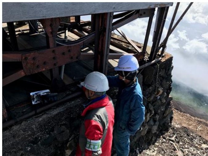
自主的補修作業の様子
