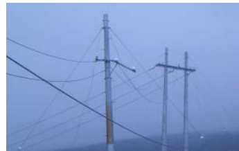
折損した69号柱と70号柱
