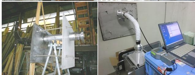
3号庁舎ダクトに取り付けが完了した新インレット(上)、工場で作成の様子(左下)、3号庁舎内の室内分岐部(右下)
