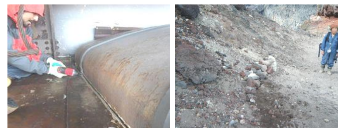
(写真左) 山頂庁舎の雨漏り補修を行う宮城公博班員(写真右) 山頂銀明館付近で発見された埋設ケーブルの応急処置をする岩崎洋班長
