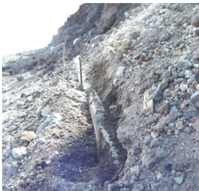
（写真）海底ならぬ海拔3700m付近で土中から露出しているのが発見された送電線ケーブル
