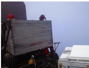
写真1 (左) 貯水槽への太陽光パネルの取り付け作業 (右上) 太陽光パネル (右下) データロガー等
