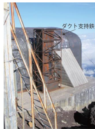
図8 回転球体法適用受雷個所等で等電位強化必要箇所と考えられるダクト支持鉄骨
