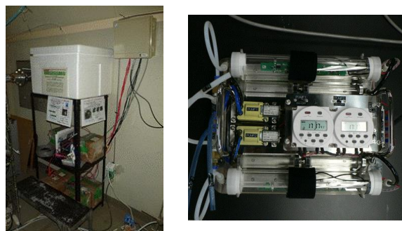
図2 施設内設置状況の一例
