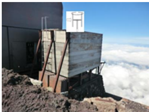
図4 小型風力発電機の設置申請予定場所
