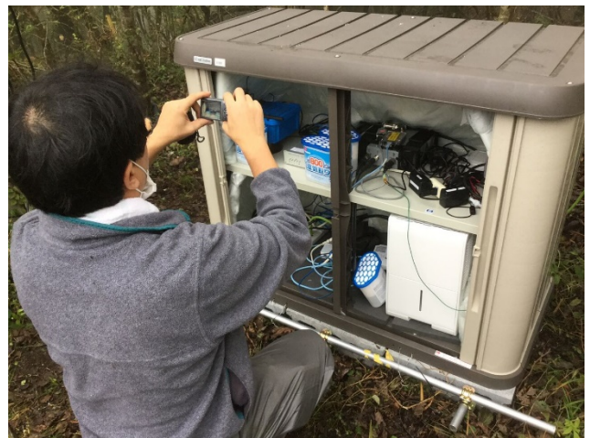
図2 2020 年 10 月に行われた設置作業.
