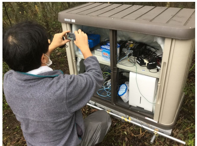
図2 2020 年 10 月に行われた設置作業.
